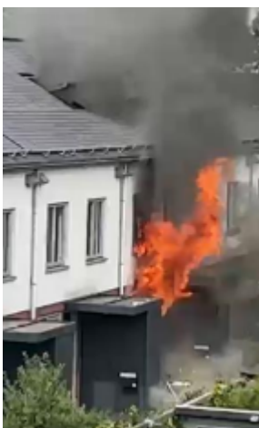
Afbeelding 3.3: Brand in keuken slaat uit en zet gevel in brand. 8
