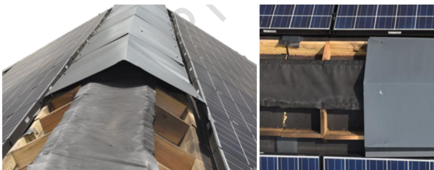
Afbeelding 4.2: Metalen afdekking van de nok. 16
