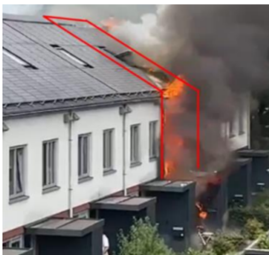
Afbeelding 4.1: Branduitbreiding vanaf gevel naar dak. 14
