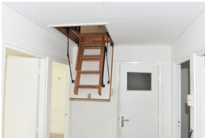
Afbeelding 3.2: Vlizotrap die toegang verschaft tot de zolder. 7
