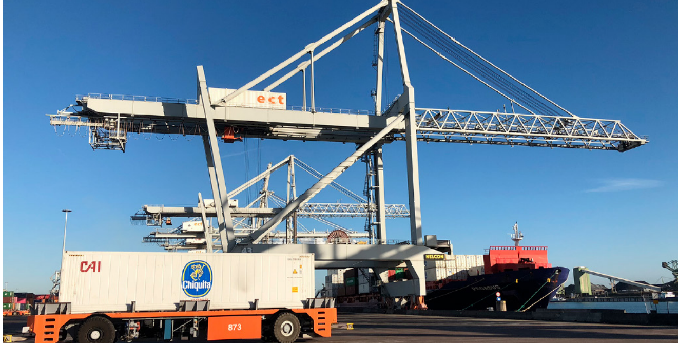
ECT containerkranen, volledig geautomatiseerd, als een van de eerste stappen naar de digitale haven. Beeld Leon Willems
