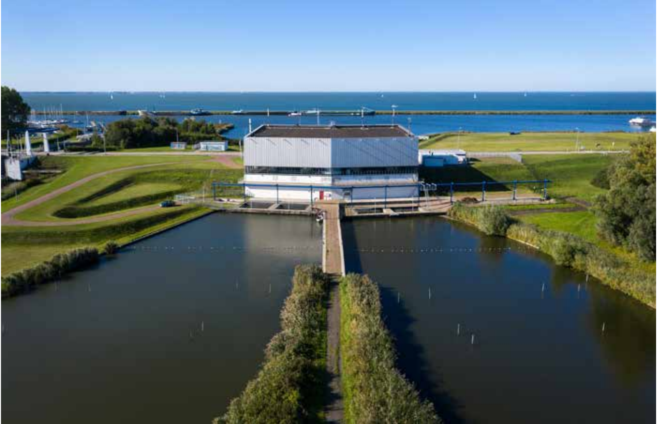
Gemaal De Blocq van Kuffeler
