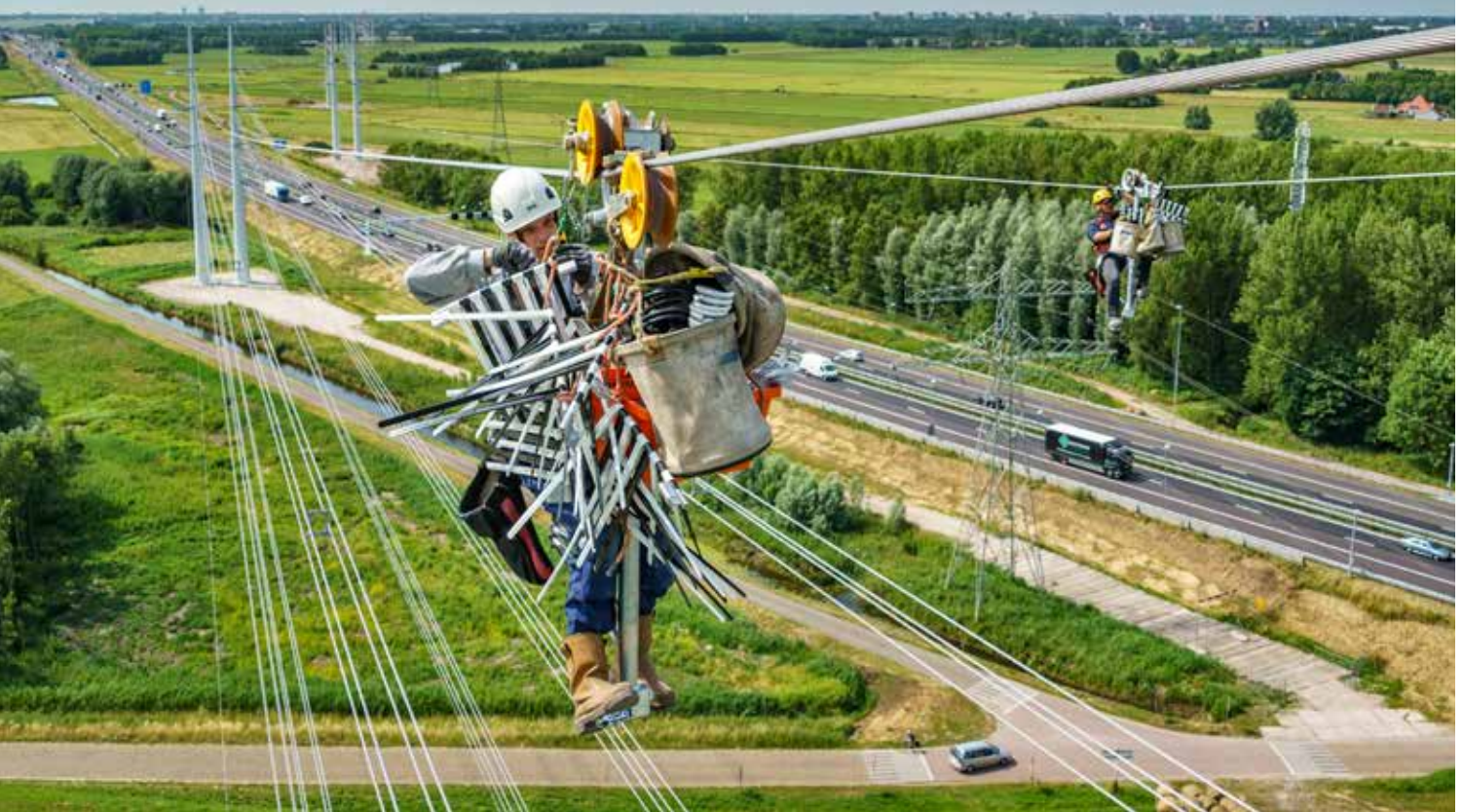
Werkzaamheden in 380 kv hoogspanningsverbinding TenneT
