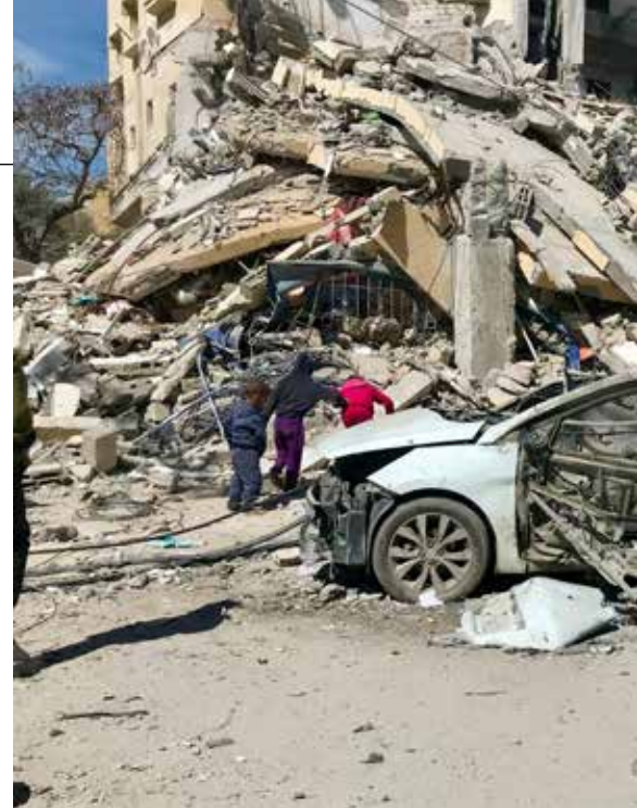
Door oorlog beschadigde gebouwen in Gaza.
