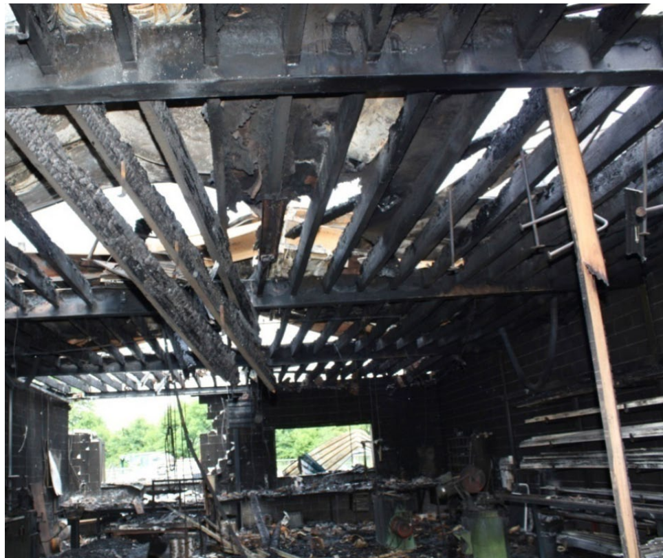
Foto 5 aluminiumwerkplaats - thermische aanval vanuit zolder naar werkplaats toe
